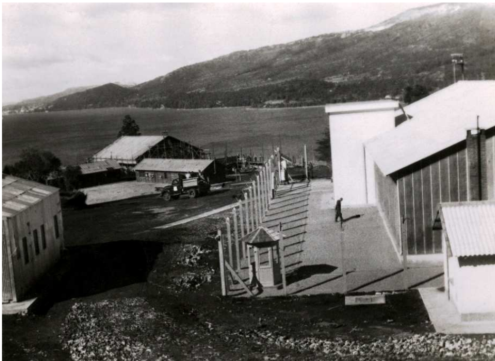
Fotos 1 und 2: Richters Laboratorium Nr. 2 mit dem späteren Anbau für die große Drossel-Induktivität
