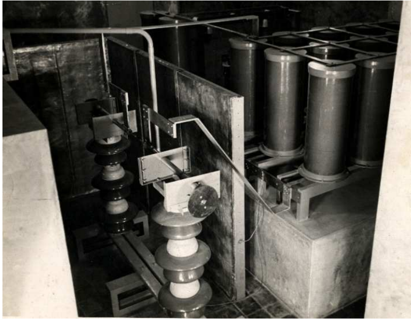
Das vordere Ende der Kondensatorbatterie. Die insgesamt 29 Töpfe haben einen Durchmesser von 40 cm mit einer Höhe von 99 cm
